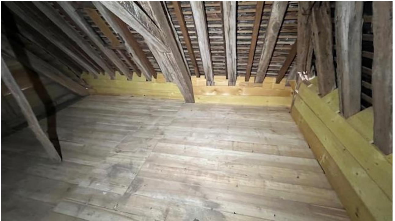
MISE EN PLACE PLANCHER AU DESSUS DE LA NEF
