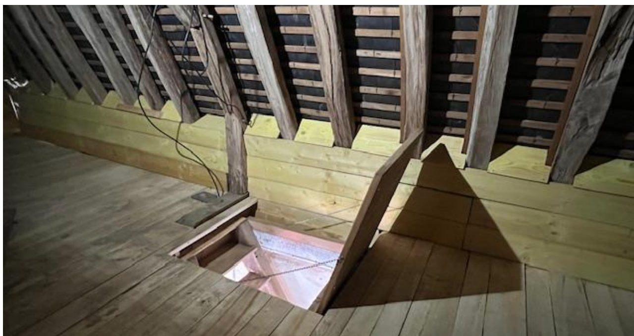
TRAPPE ACCES PLANCHER AU DESSUS DE LA NEF
